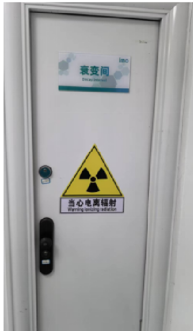
废物（衰变）间防护门外电离辐射警告标志
