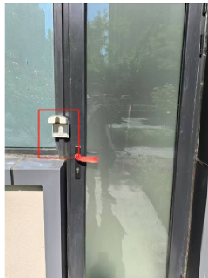
西侧调试场所外入口门禁
