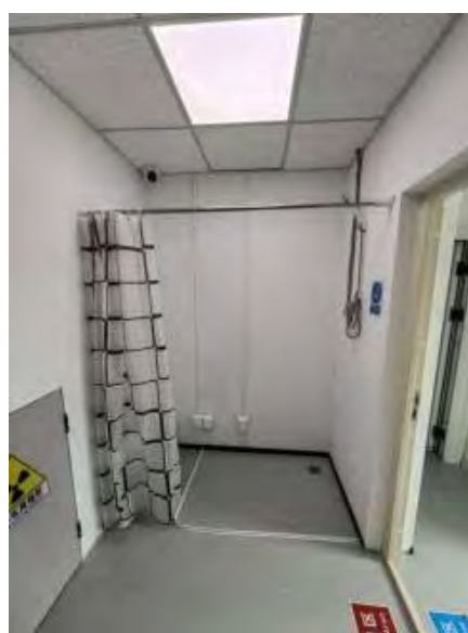
应急淋浴室设地面围挡和浴帘
